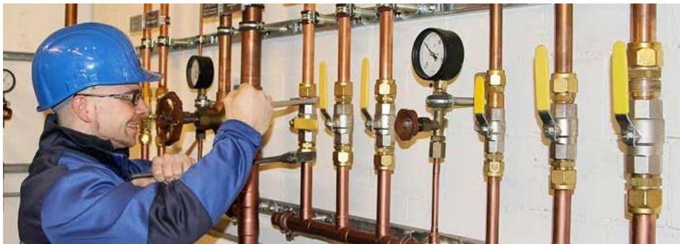
Stefan Fuchs, montér společnosti Messer ve Švýcarsku, instaluje potrubí systému zásobování medicínskými plyny v nemocnici.
