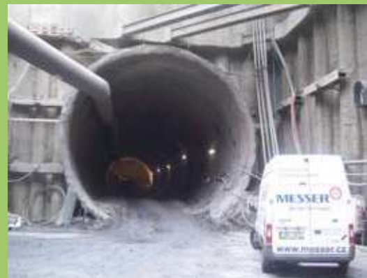
Na rozšíření pražského metra bylo poptáváno know-how společnosti Messer
