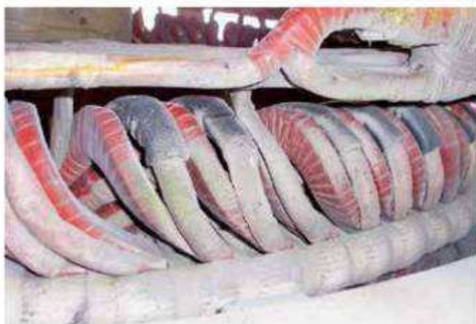
Vnitřní generátoru elektrárny před a po čištění peletami suchého ledu.
