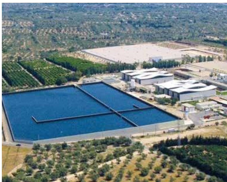
Vodáreň CAT využíva vodu z rieky Ebro.
